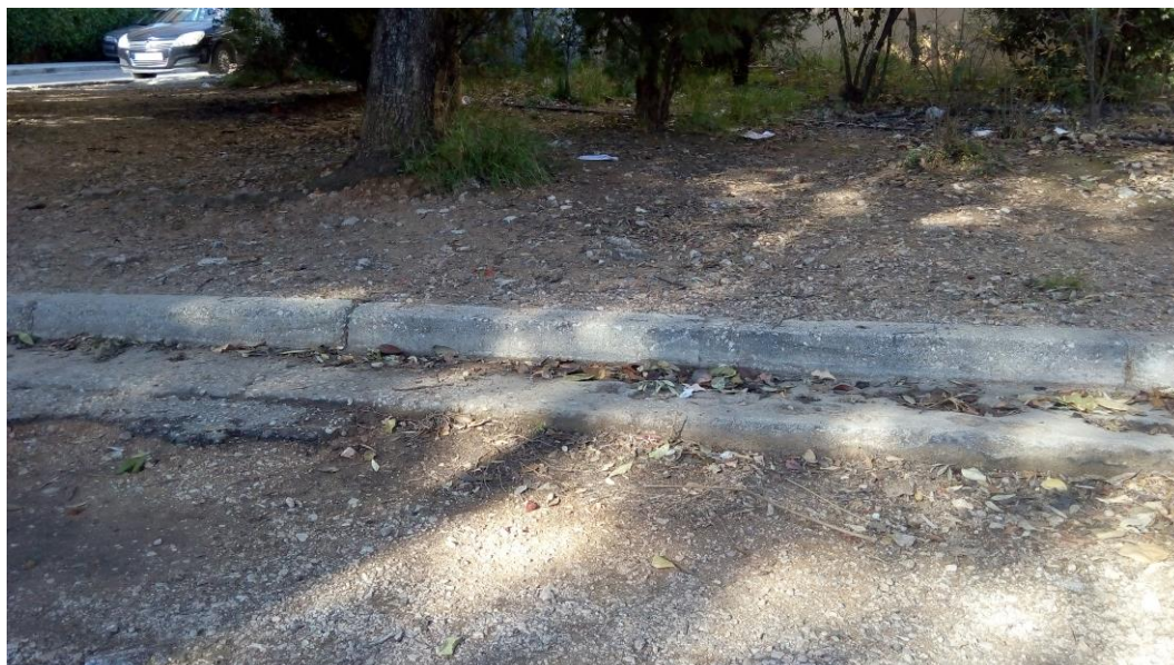
Οδός περίξ της συμβολής Κολοκοτρώνη και Βέργας
